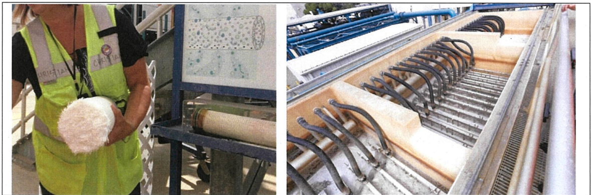
圖 8 本廠 MF 所採用的膜型式及 MF 之模組單元操作情形
