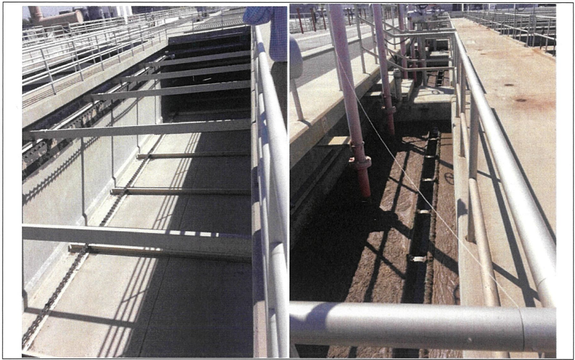
圖 23 本廠生物處理池採用 AO 除氮程序，二沉池採用矩形沉澱池(非金屬鍊條刮泥機)
