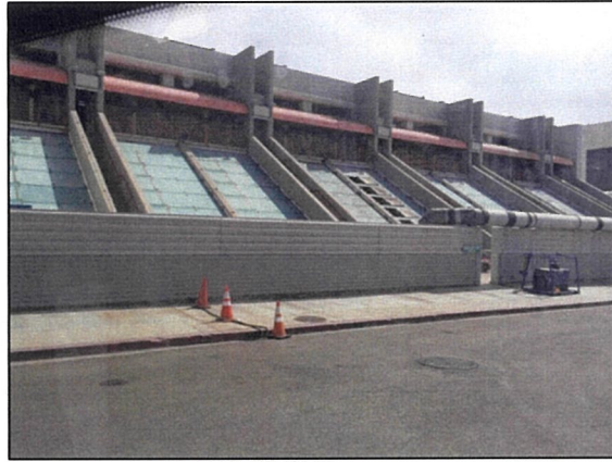
圖 3 本廠中繼加壓站
