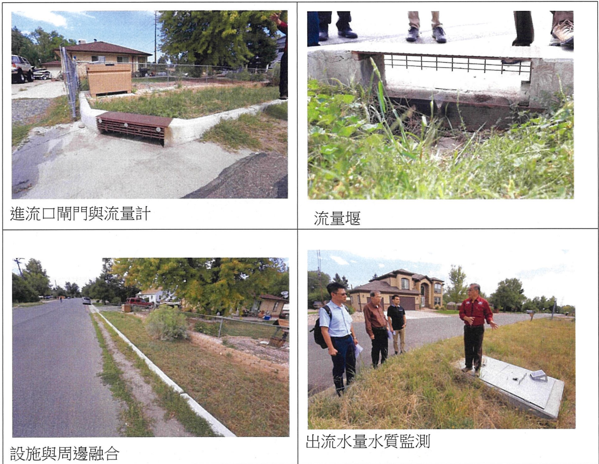
圖 33 21 st street and Iris Rain Garden 勘查照片
