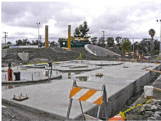
設備施工階段
