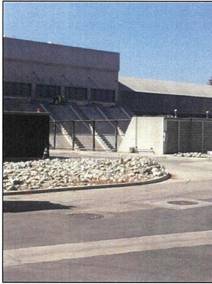
圖 21 螺旋抽水機(整修中)
