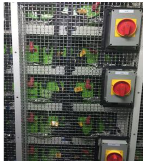
600V/240kWh 鋰電池
