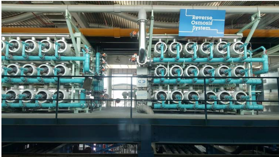
圖 3、樟宜水再生廠之 RO 薄膜處理程序
