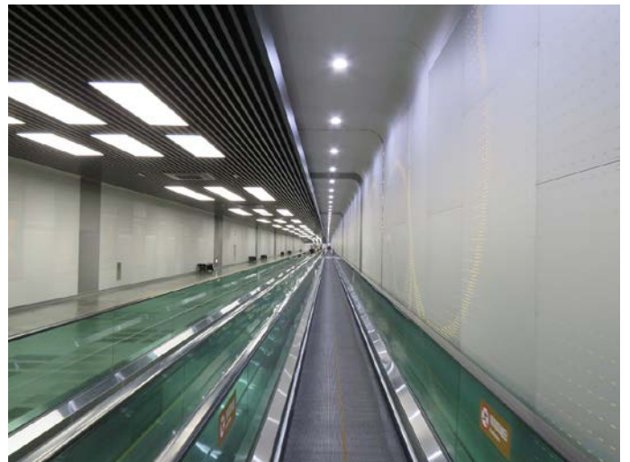
國立中央博物館地鐵站內提供電動步道(Moving walkway)服務
