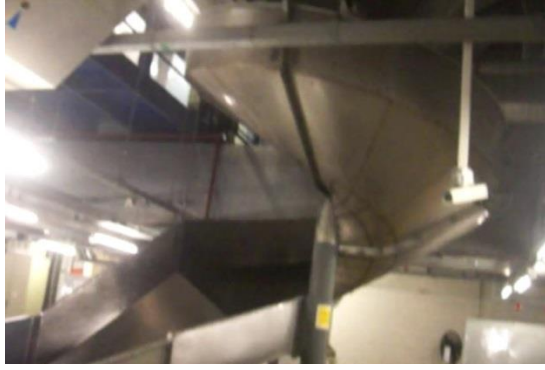
圖 4.4.3 市中心車站行李處理螺旋滑槽
