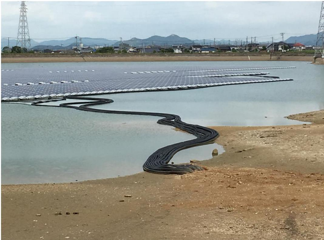
圖十一、漂浮式太陽能電廠線排匯整後至岸邊
