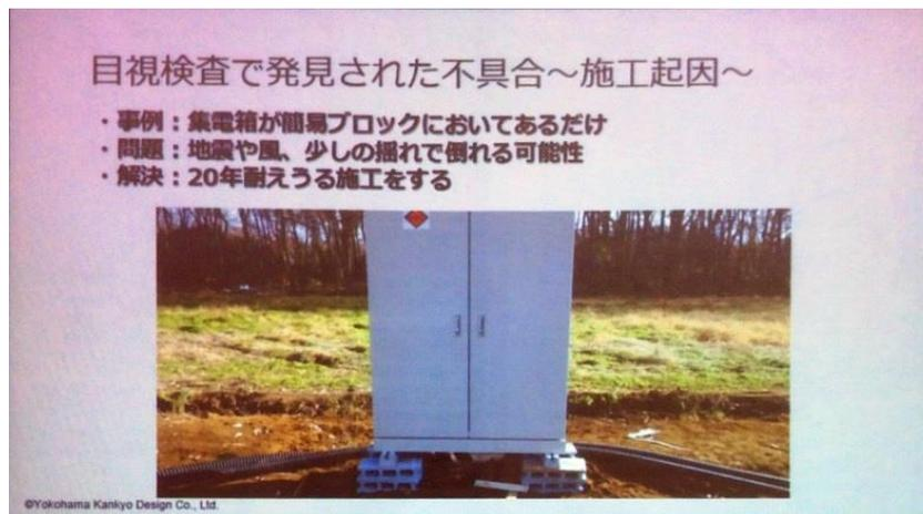
圖四十二、狀況：配電箱未固定於地面，可能因地震或颱風損害
