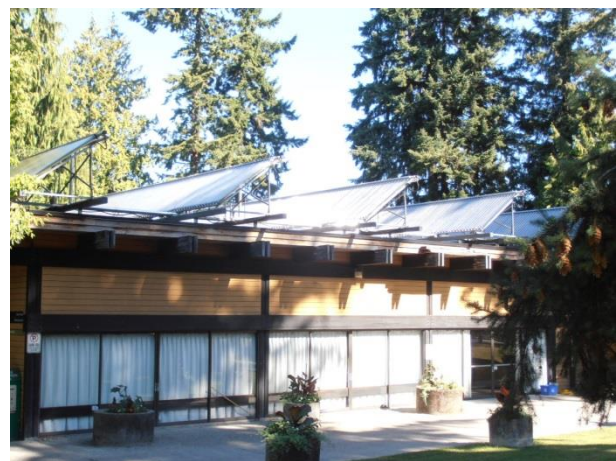
圖 3-3、遊客中心屋頂集熱系統
