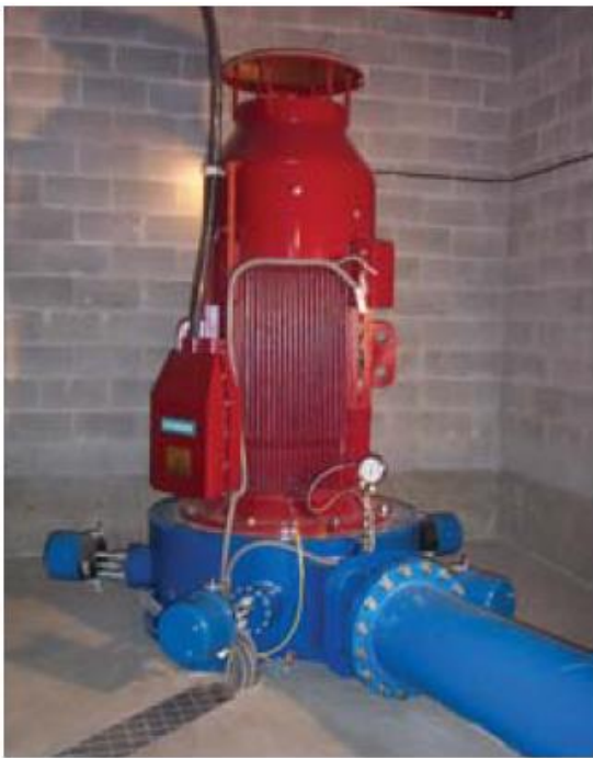
圖 4-1、西溫哥華市區於自來水管裝設微水力發電系統(200kw)替代減壓閥
