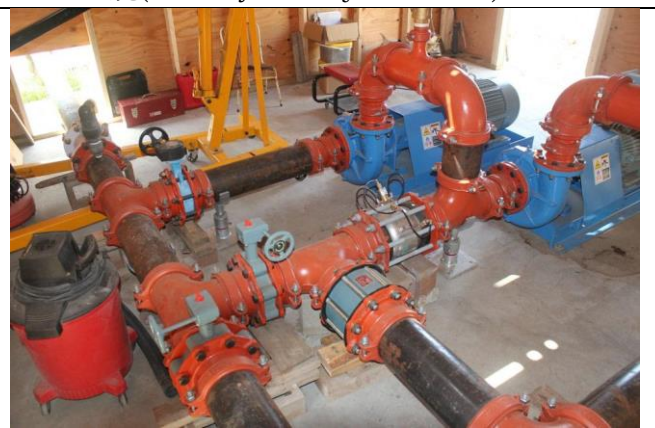
圖 4-2、北溫哥華市區自水管減壓水力發電系統(PRV Hydro Project，23KV)
