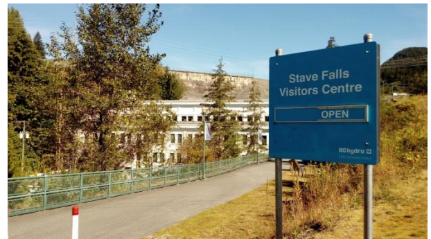
圖 3-11、Stave falls 發電站遊客中心入口
