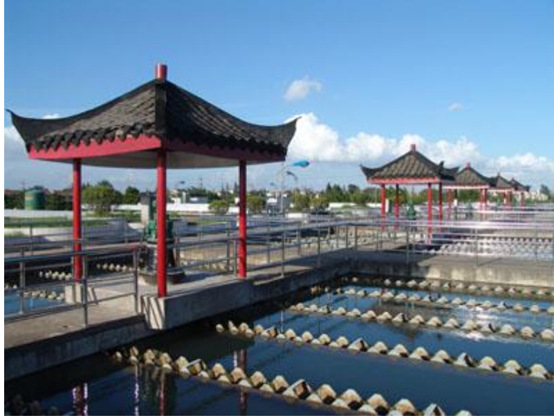
狼山水廠沉澱池
