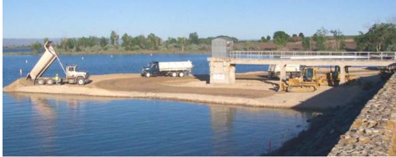
進水口工作區回填
