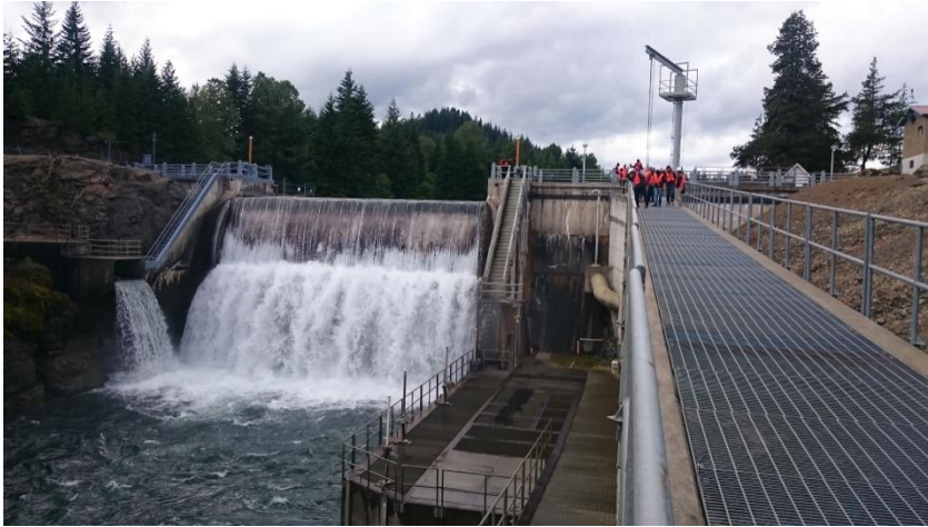
導流堰溢流口及魚梯
