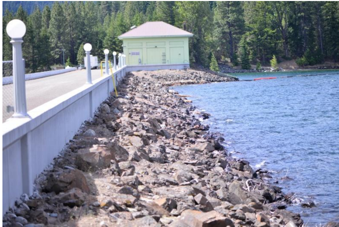
以長焦距鏡頭檢視上游拋石邊坡
