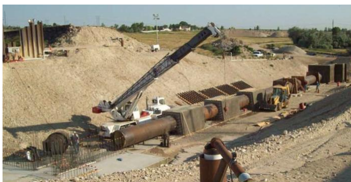
更新導水渠道
