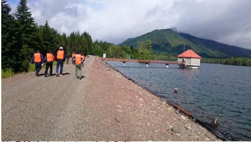
壩頂鋪設碎石級配，表面平整
