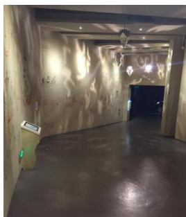
圖：數字館入口無障礙坡道
