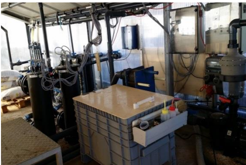
Argenton 研究站貝類繁殖場海水處理系統
