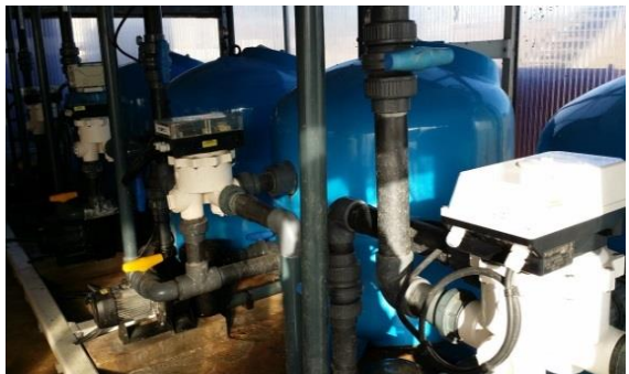
Argenton 研究站貝類繁殖場海水處理系統
