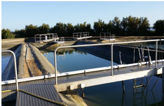
Argenton 研究站海水蓄水池
