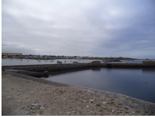
Argenton 研究站海水蓄水池
