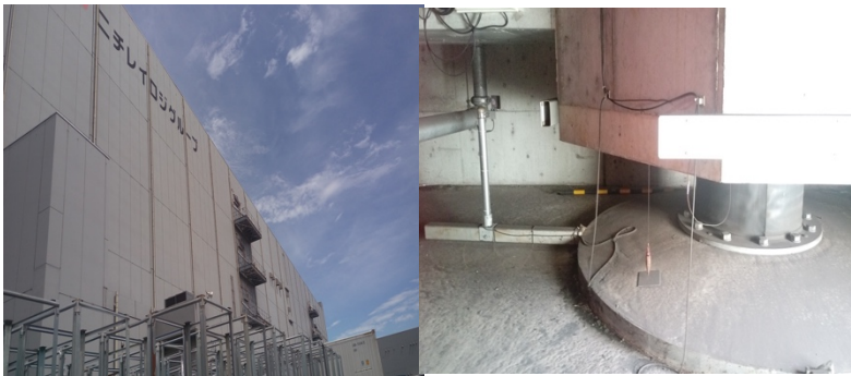
圖九、Nichirei logistics 東扇島物流中心外觀與東扇島物流中心避震設施
