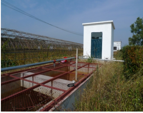
圖十七、耐寒檢定系統之定溫蓄水池及電腦控制室
