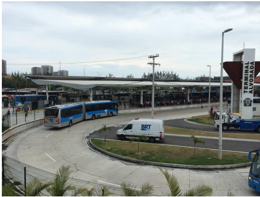
圖 6.13 提升 BRT 車站月台
