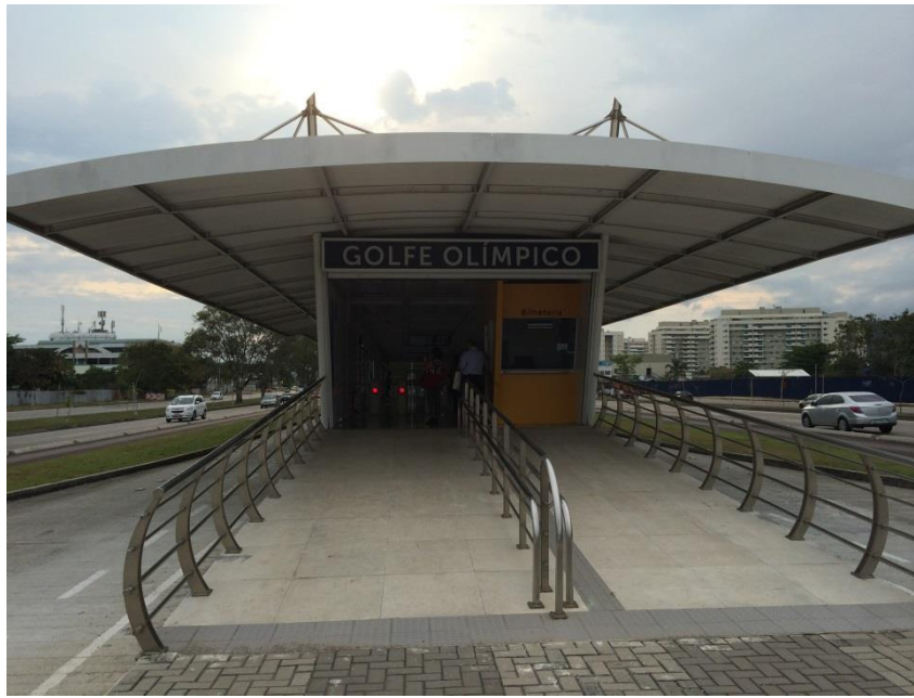
圖 6.15 BRT 車站入口
