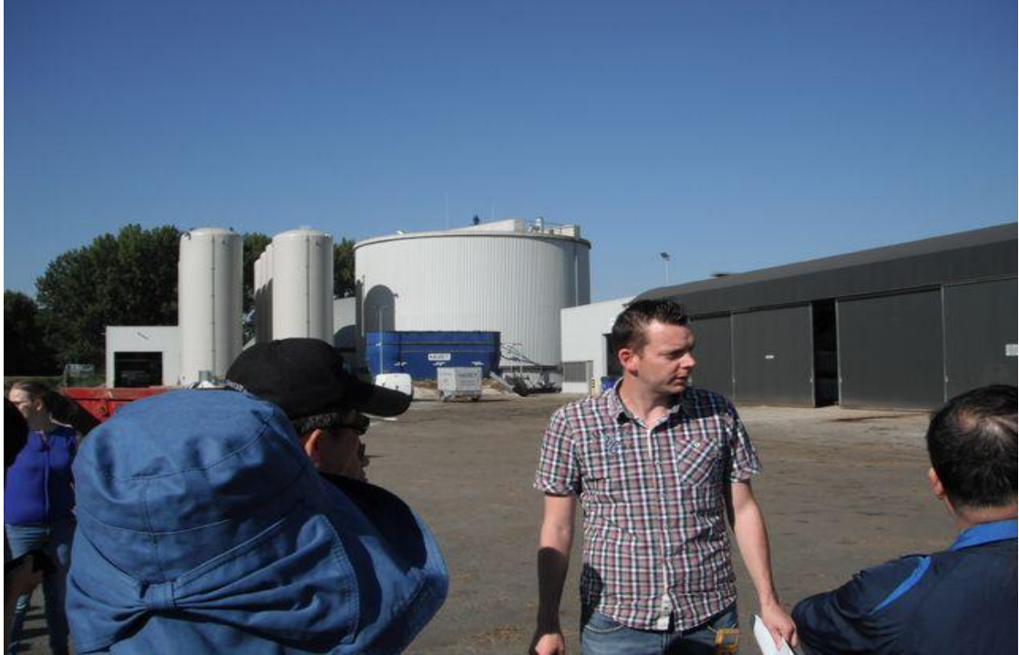
圖 30 廠方專業人員解說(後方為主消化槽)
