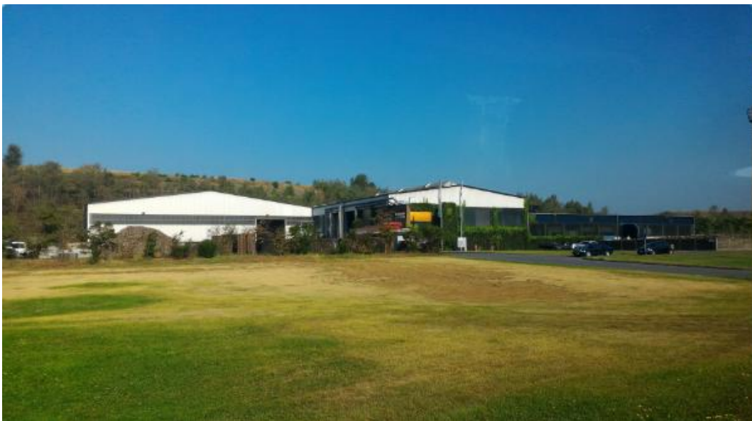
圖 7 自動堆肥場、採負壓方式防止臭味
