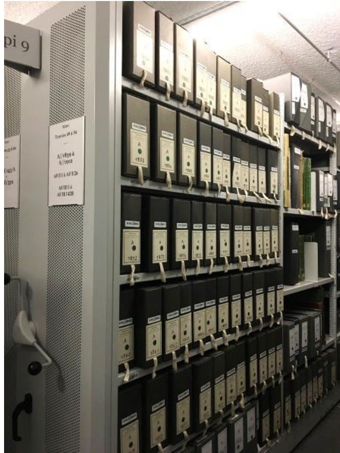
圖 3- 19 新館檔案架封板(金屬沖孔板)情形 (來源：自行拍攝)
