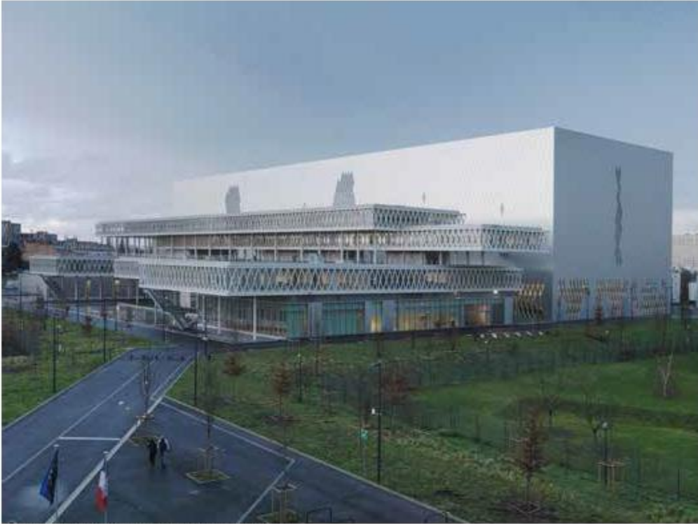
Bâtiment des Archives nationales, architectes M. et D. Püschel
