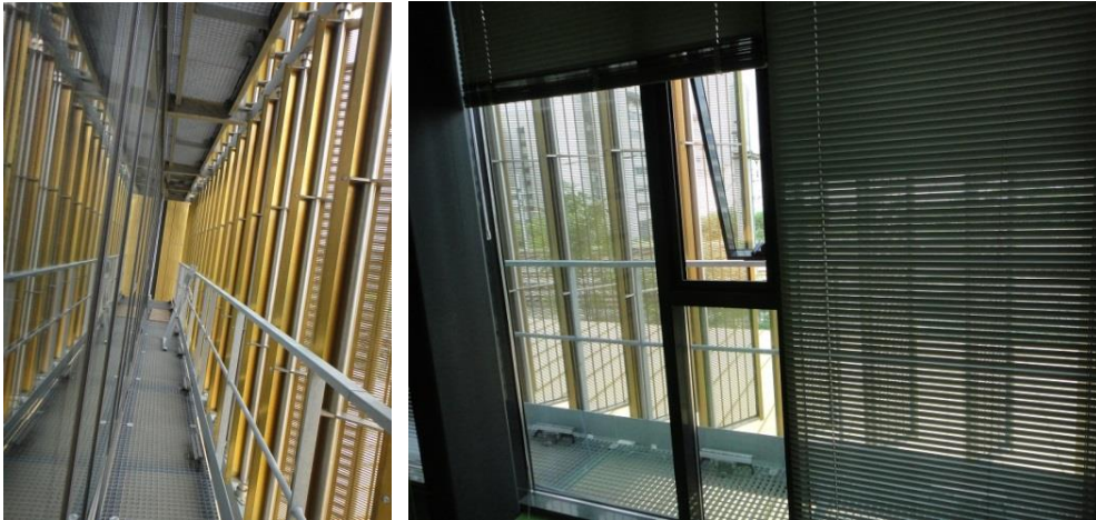
圖 4- 20 羅納省檔案館檔案整理室外部及內部遮光設備 (來源：自行拍攝)
