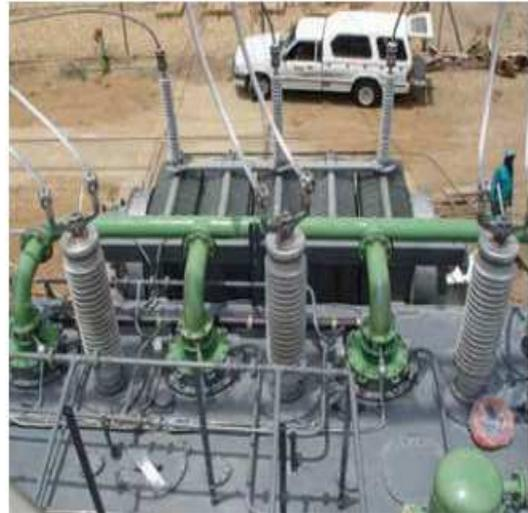
圖 3-3 快速釋壓緩衝室及氮氣噴發系統
