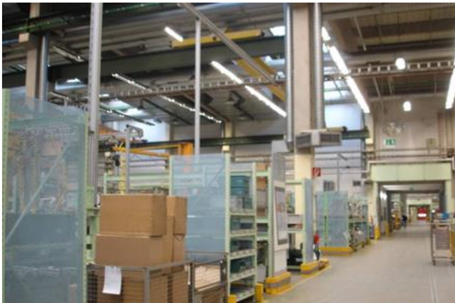
圖 3-48 變電系統製造工廠廠房
