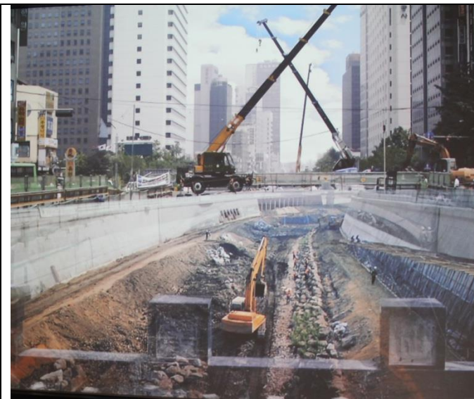
圖13_清溪川整治時施工情形
