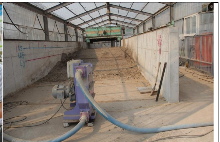
圖28_口蹄疫掩埋區域土壤處理區
