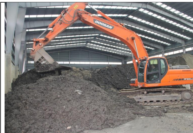
圖17_H-Plus 公司污染土壤離場篩分作業
