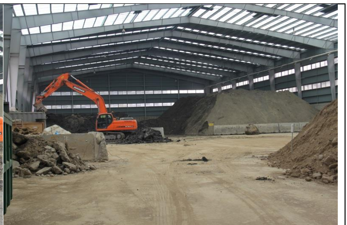
圖18_H-Plus 公司污染土壤離場篩分作業
