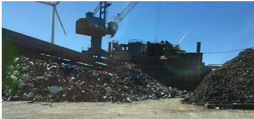
圖十四 Gallo 廠區現場作業情形
