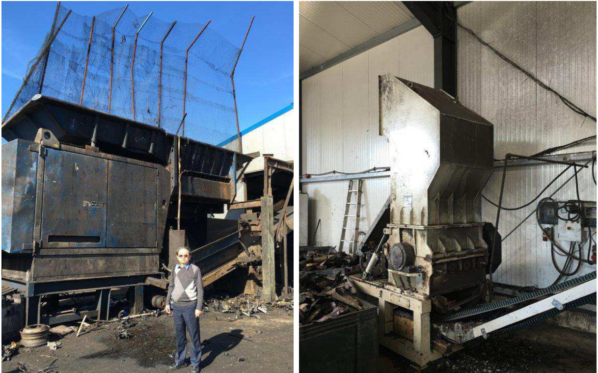
圖八 廢車破碎及分選設備
