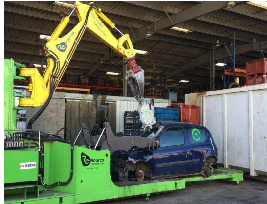
車窗玻璃拆卸
