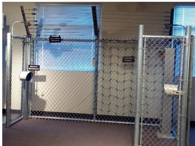
圖 3、核子保安安全圍籬及偵測設備
