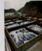
某医药废水处理及回用 示范工程
