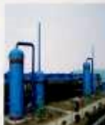
杭州湾化工园区集中污水处理 系统臭气净化工程
