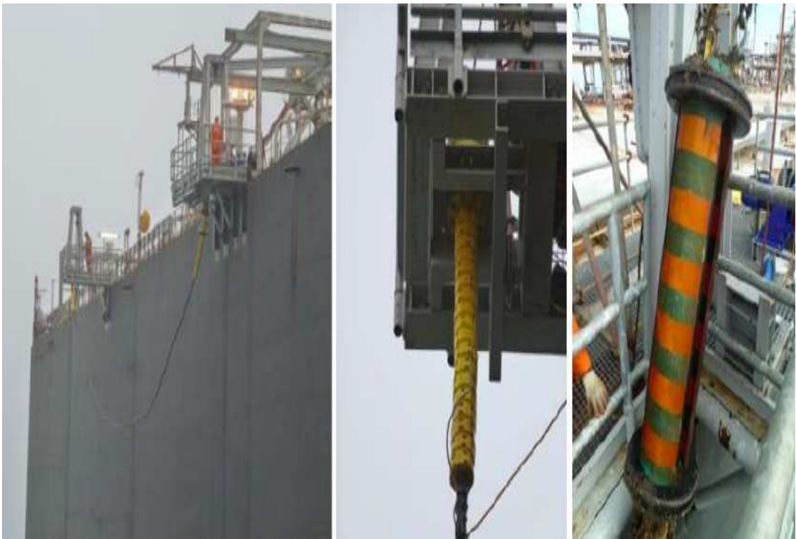
圖六 海上浮式儲槽的懸掛式陽極及其安裝方式
