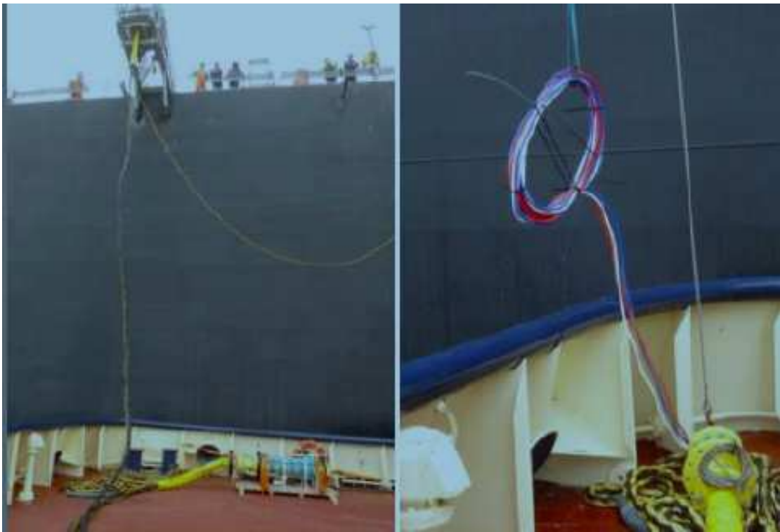
圖七 陽極懸吊作業方式
