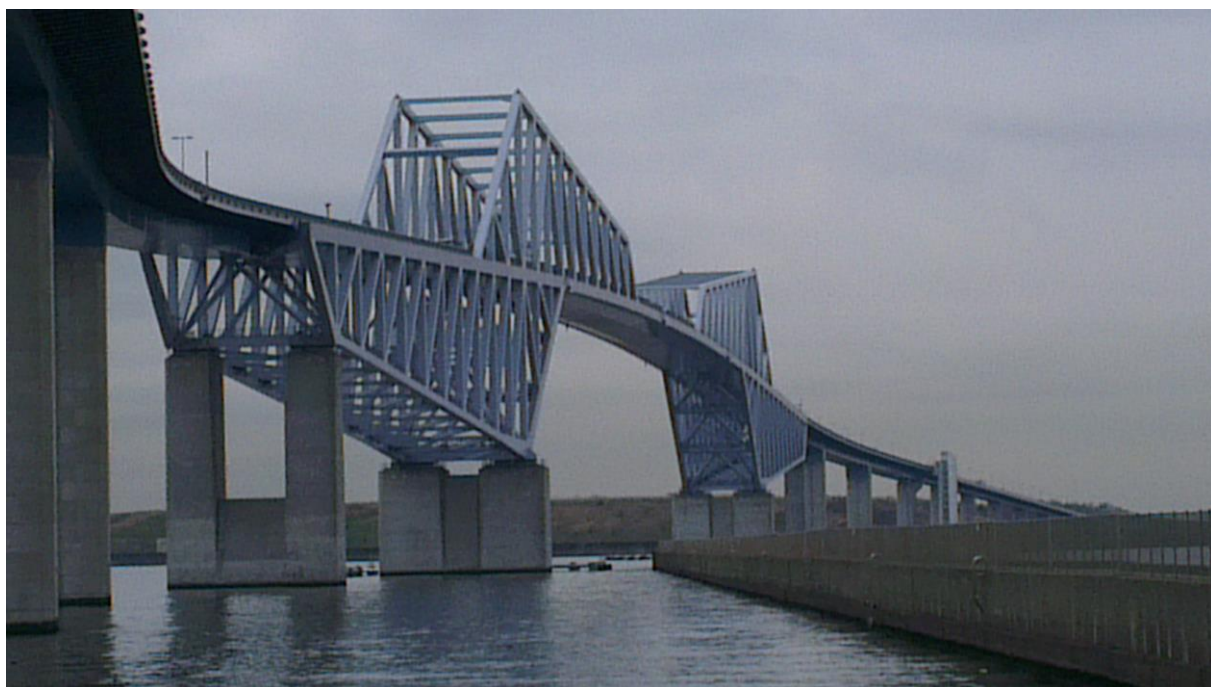
東京灣大橋工地參觀
