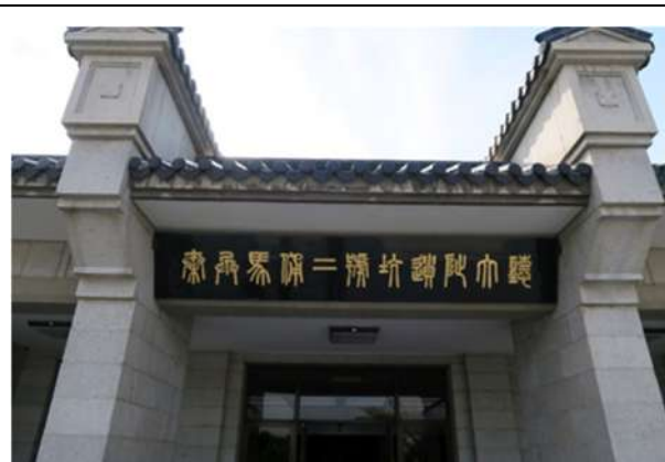
秦兵馬俑二號坑遺址大廳入口。
