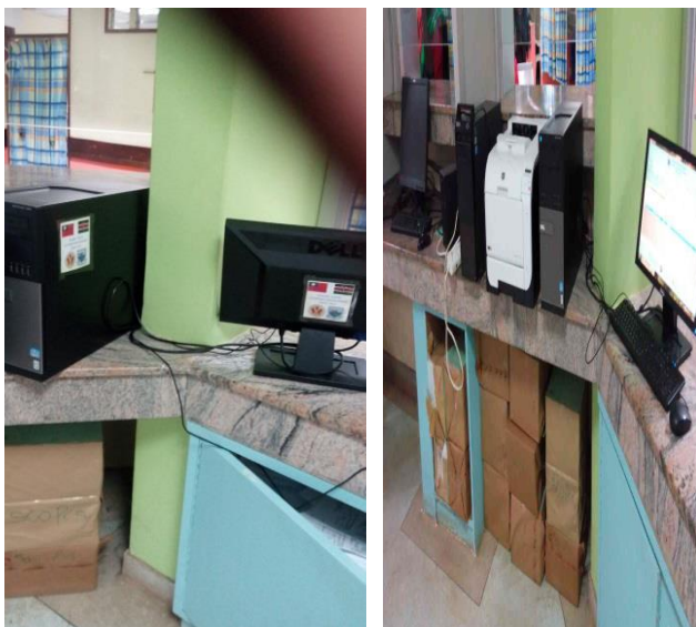
▲檢傷系統設置
