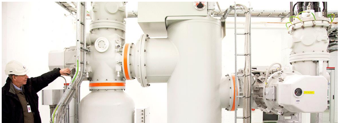
圖 5. 對組裝完成的整體 GIS 進行測試示意圖
