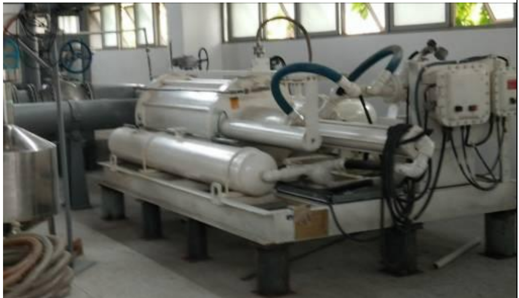
上圖為油庫油量計檢定用之標準裝置
