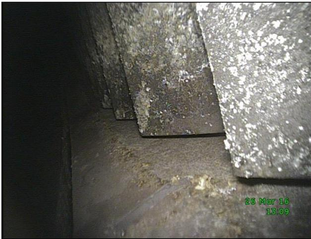
圖八：#1 葉片部份塗層剝落及腐蝕
