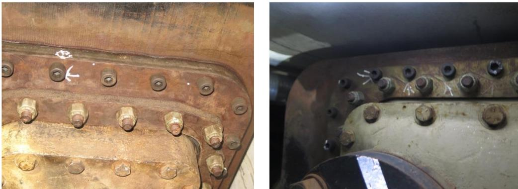
圖十七：H2 cooler 端板洩漏位置
