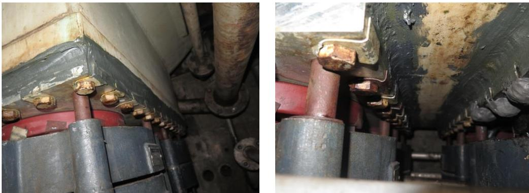
圖二十：高壓套管洩漏點修補情況
