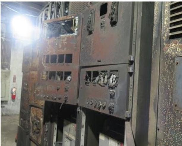
圖六：#1 機斷路器箱燒損情形
