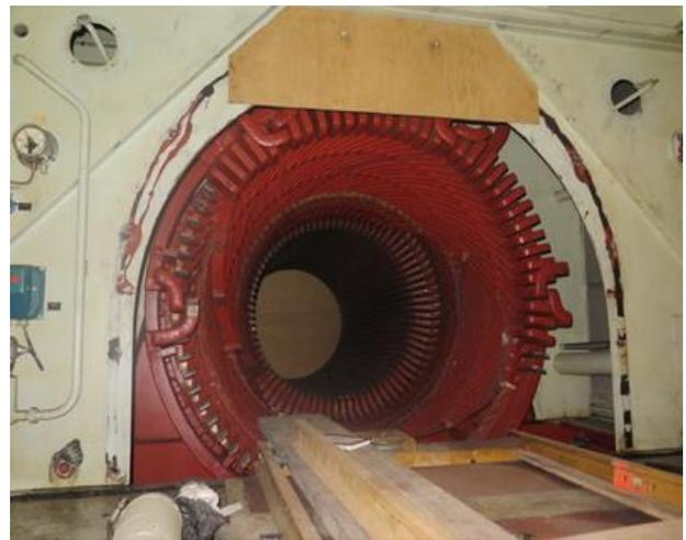
圖七：#2 機發電機轉子拆出情形
