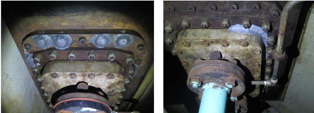
圖十九：H2 cooler 端板洩漏點修補情況
