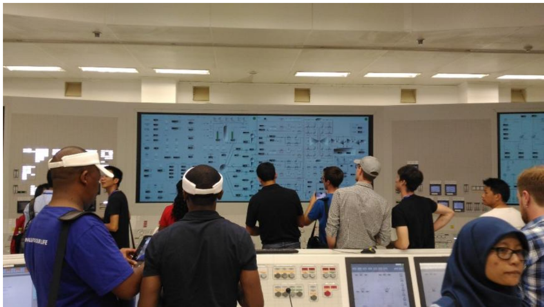
圖 22 方家山電廠採用 DCIS 儀控技術
