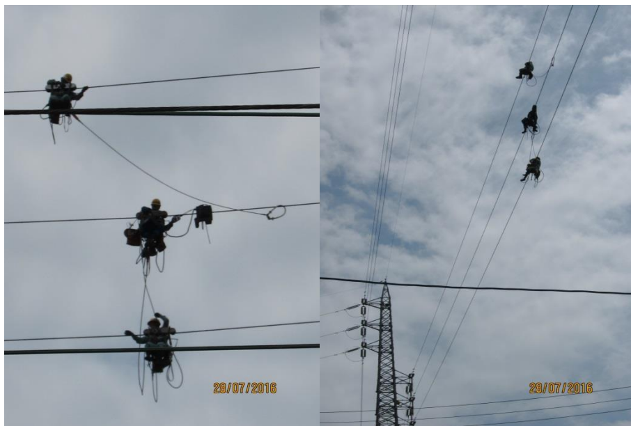
圖 19 導線腐蝕檢測見習-3
