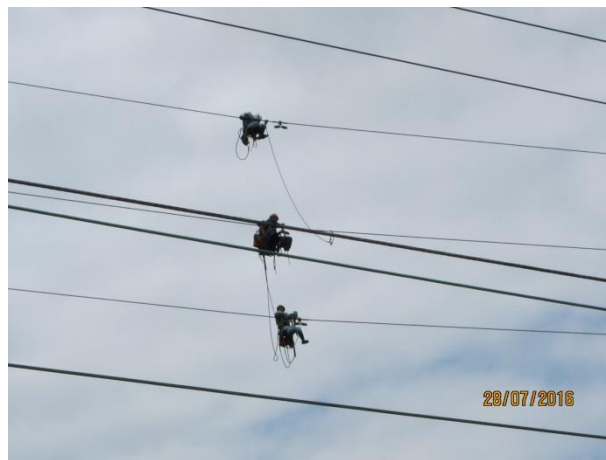
圖 18 導線腐蝕檢測見習-2
