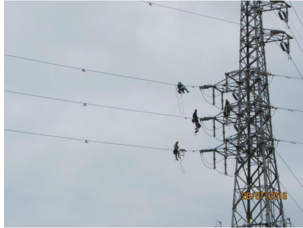
圖 17 導線腐蝕檢測見習-1
