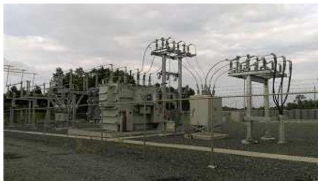
圖 3.9 燃料電池發電廠主變壓器與開關
