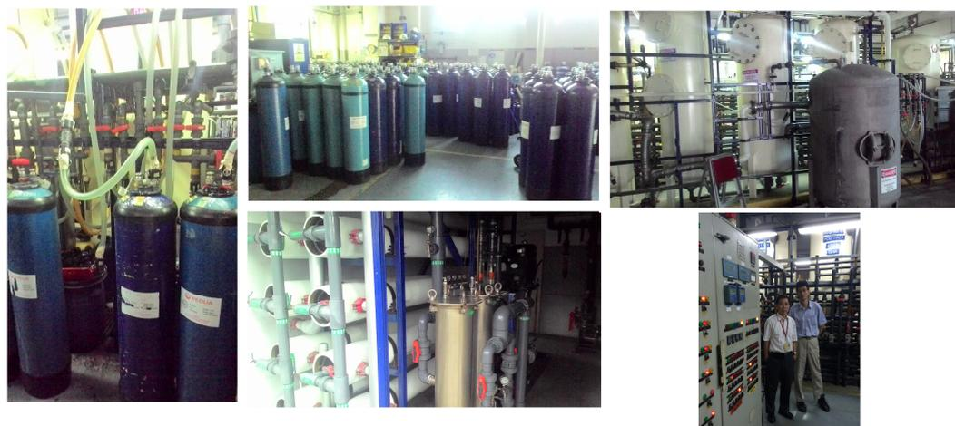
圖 36.左圖樹脂抽出準備做交換；中上圖 FRP 樹脂桶；中下圖 RO 膜造水設備供水給樹脂做再生清洗用；右上圖桶槽照片；右下圖筆者造訪現場照片。
