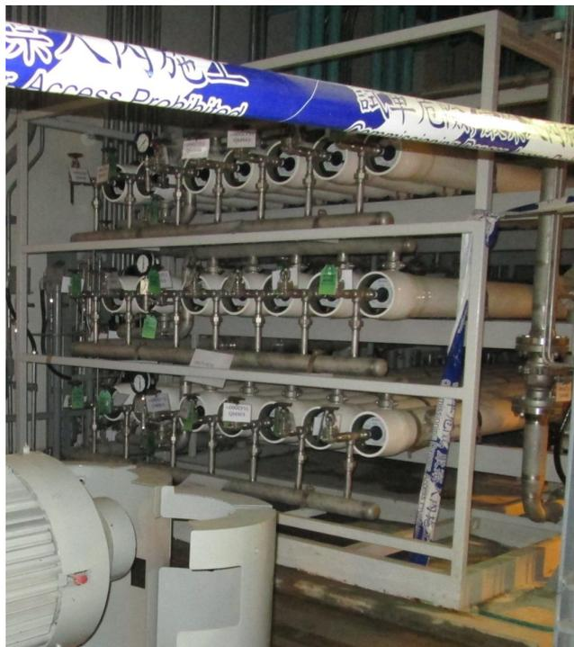
圖26.林口除礦水廠RO系統設備圖
