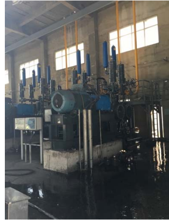
圖八、水煤漿工廠內部。
