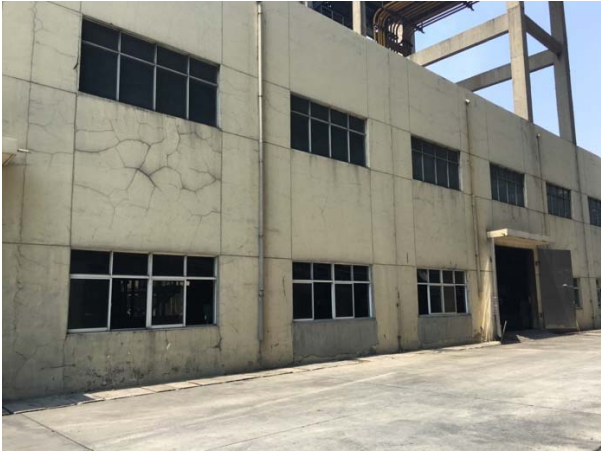
圖七、水煤漿工廠外觀。
