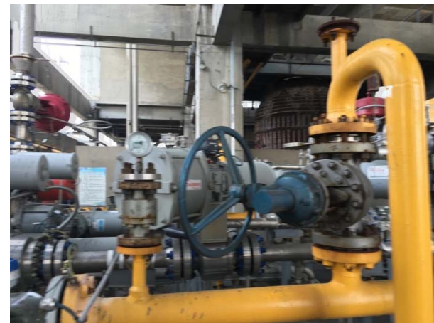
圖十二、水煤漿送漿系統。
