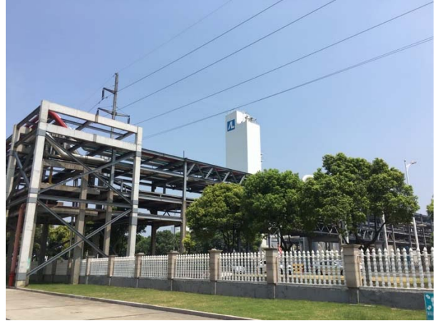
圖四、法國 Air Liquide 空氣分離廠。
