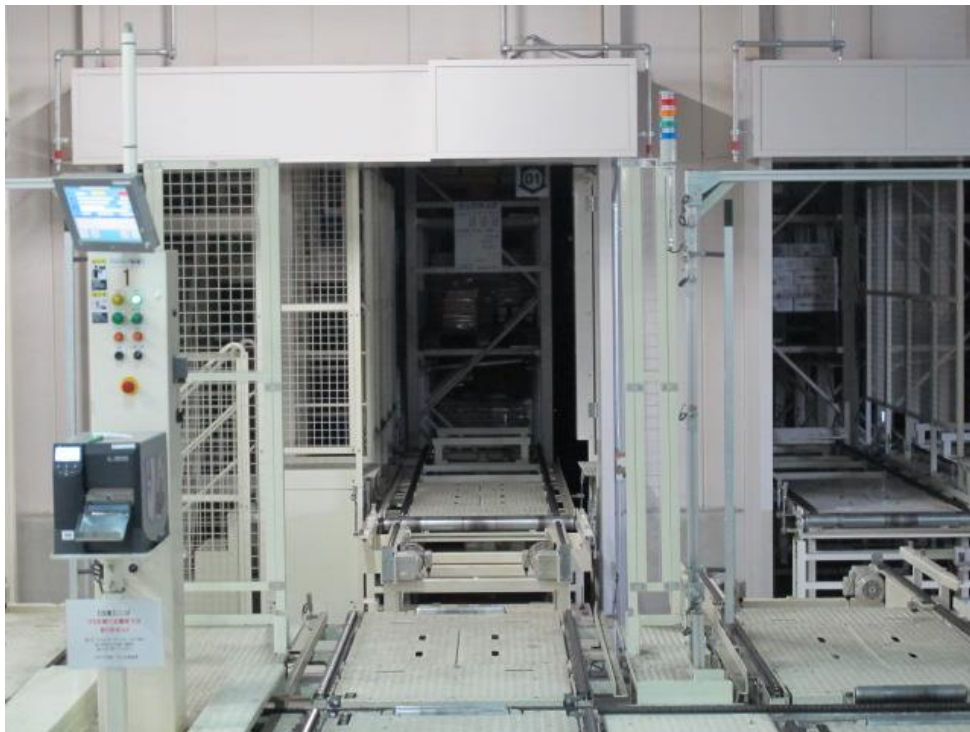
圖 4.1 棧板自動倉庫入庫 Port 圖
