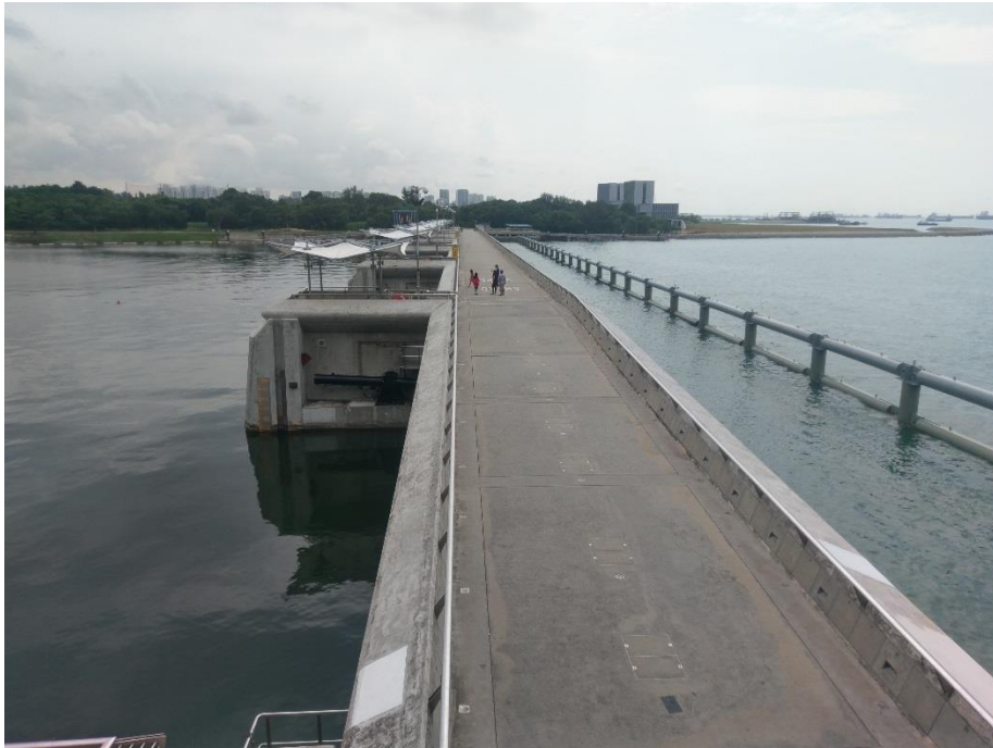
圖七、105.7.14(四)參觀新加坡濱海堤壩。
