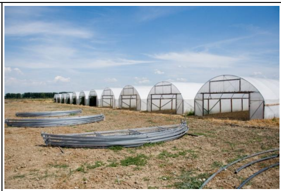
塑膠布遮雨設施
