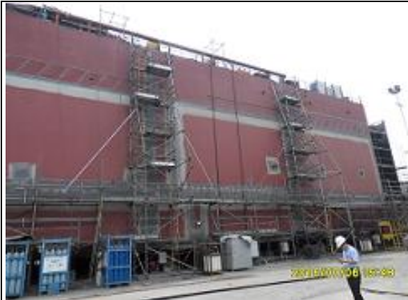
板搭架施工(西貢船廠)
