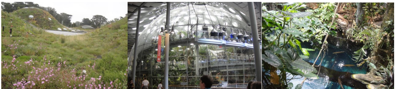
圖 3. 加州科學院博物館第二進室內熱帶雨林溫室。左：溫室自然採光之屋頂（左上半圓弧）及屋頂植物園。中：室內熱帶雨林溫室。右：溫室內雨林淡水生態池是玻璃底，觀眾在地下室水族館可從其玻璃底下方走到通過，仰頭觀賞雨林水族。
