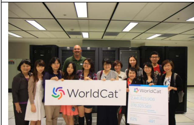
參觀 OCLC data center
