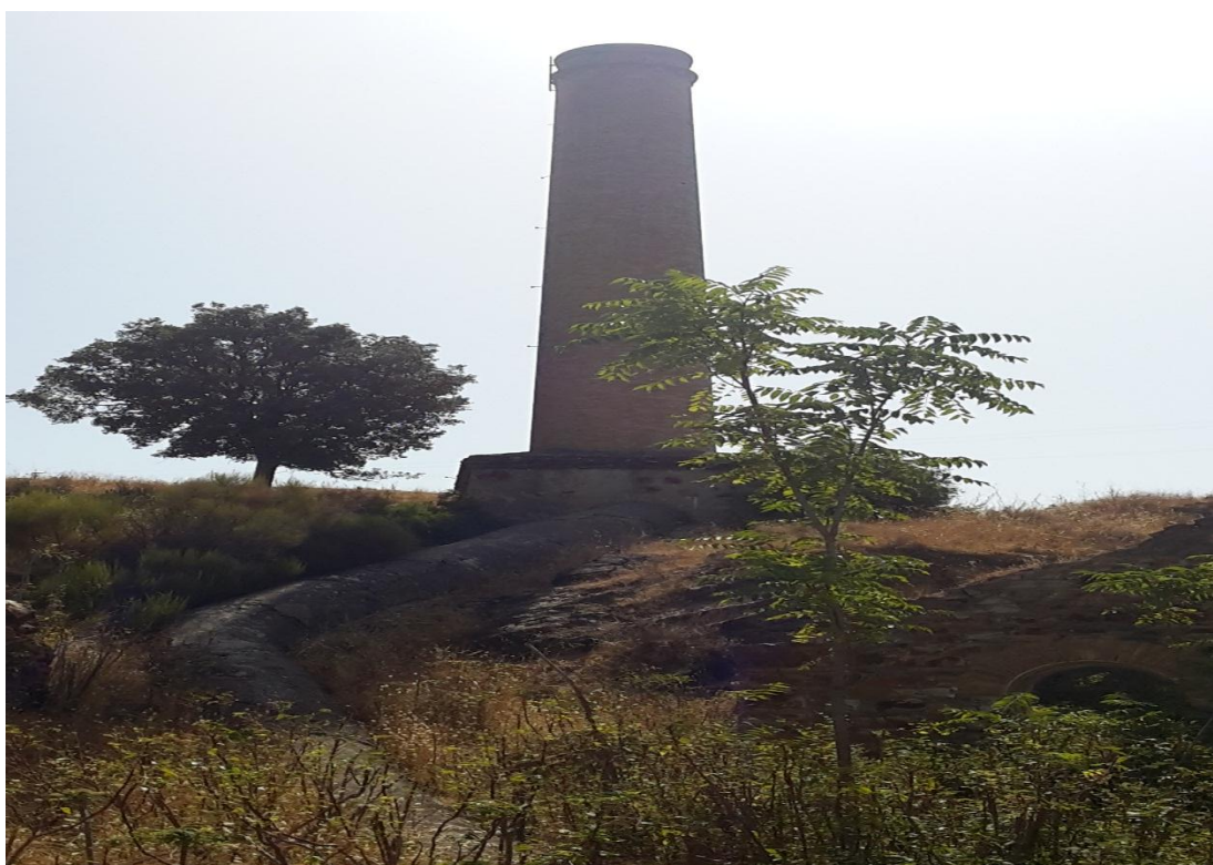
照片 4 排煙道與煙囪（二）
