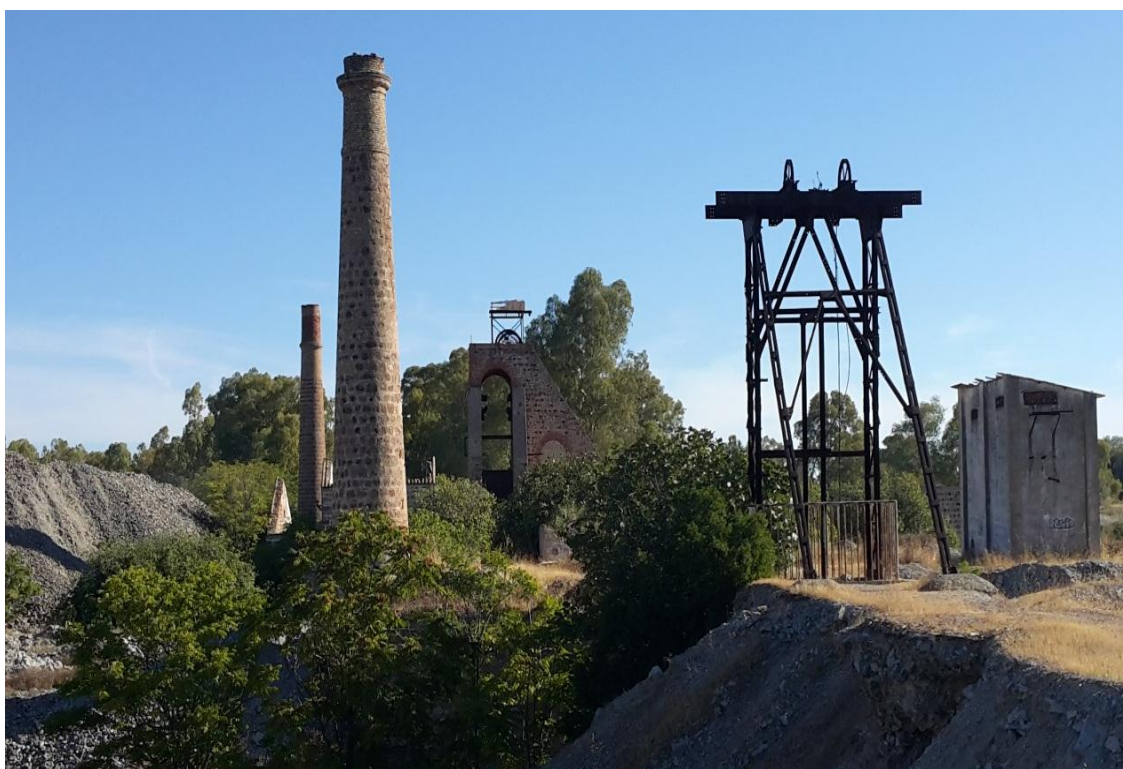
照片 6 直井、煙囪、引擎房
