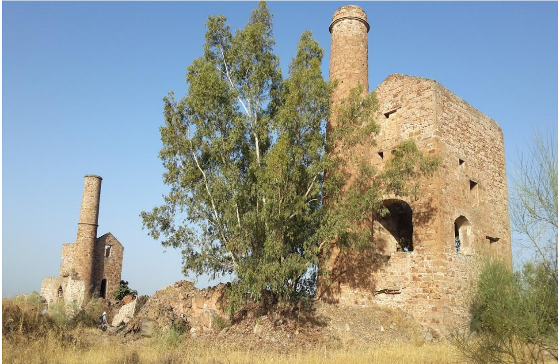
照片 7 煙囪與引擎房
