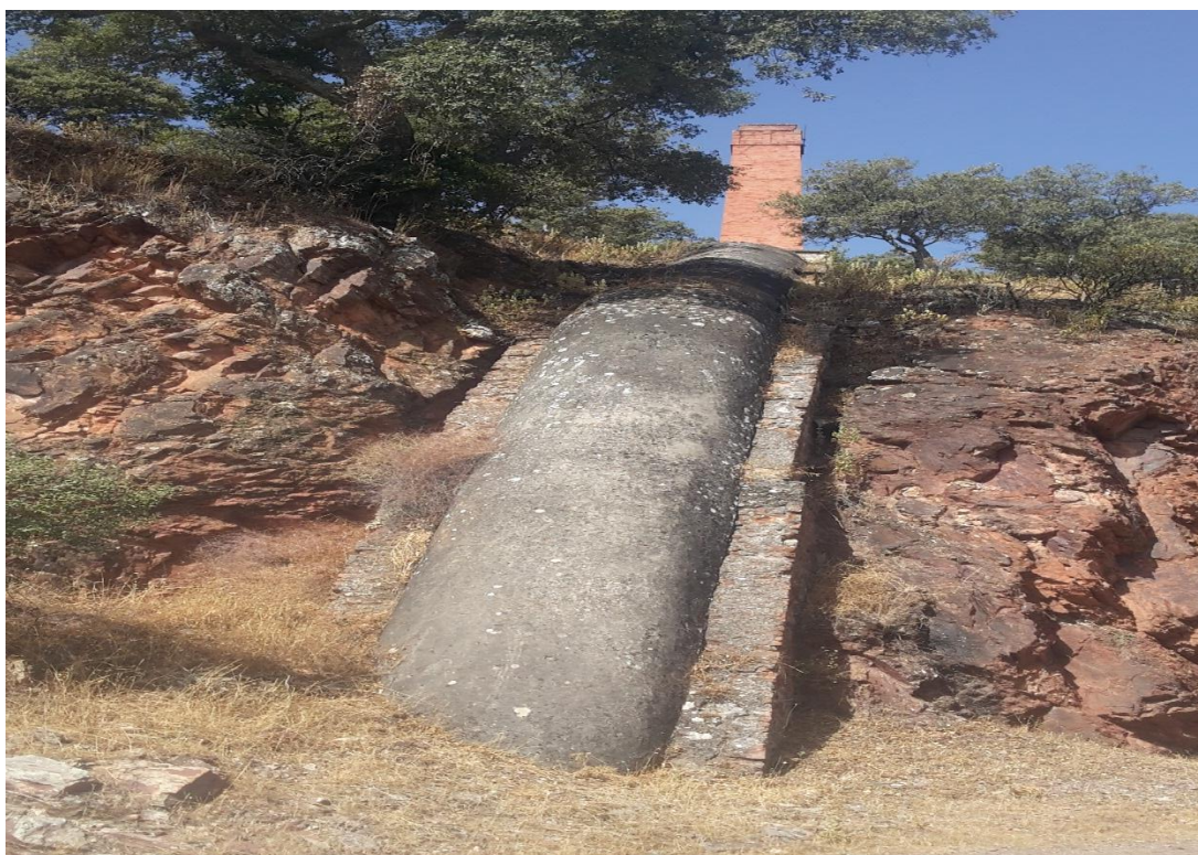
照片 3 排煙道與煙囪（一）
