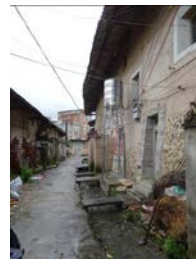
照片 30 在田樓外部增設開 口部及廁所
