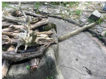
照片 15 和陽樓內部水井封閉及水管
