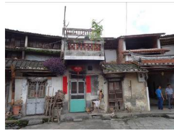
照片 28 鳳山樓內部增建二 樓空間
