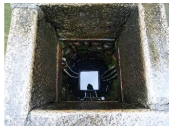
照片 16 在田樓內部水井及水管
