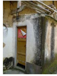
照片 26 廣福樓內部增建廁 所空間
