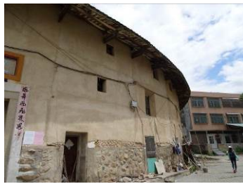
照片 29 鳳山樓外牆增設開 口部
