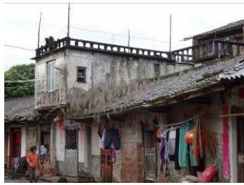
照片 27 在田樓內部增建二 樓空間
