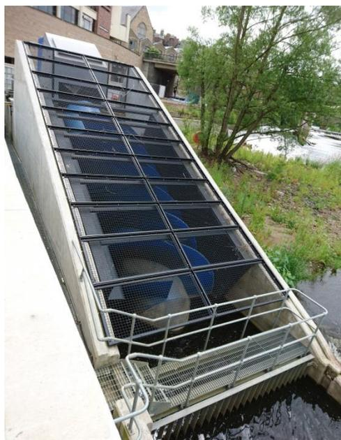
圖13：Archimedes Screw水輪機
