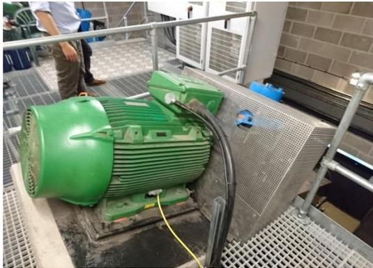
圖4：Persnore Weir電廠發電機
