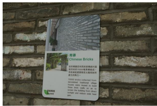
拆卸傳統村屋回收再利用象徵的青磚牆，並提供降低建築物受陽光照射產生的熱力
