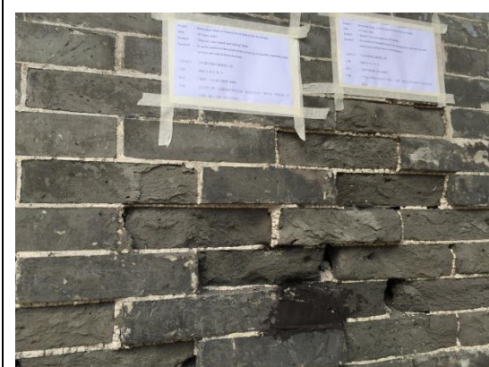
北帝廟外牆修復工程
