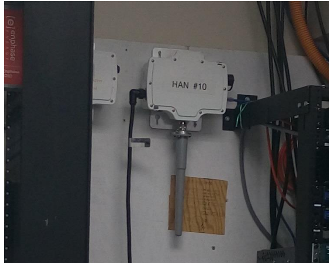
圖 8 PG&E 智慧電表系統所使用的通訊集中器
