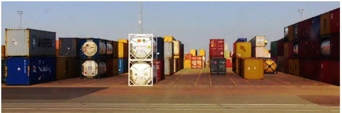
危險品櫃專區車行通道加寬及分區隔離情形，資料來源:自行拍攝
