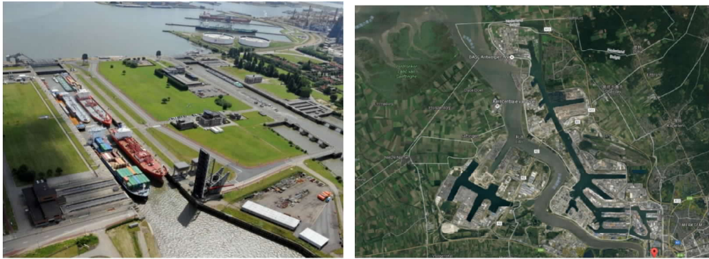
位於安特衛普港的船閘(左)，以運河挖入方式建構碼頭(右)，資料來源:課程講義
