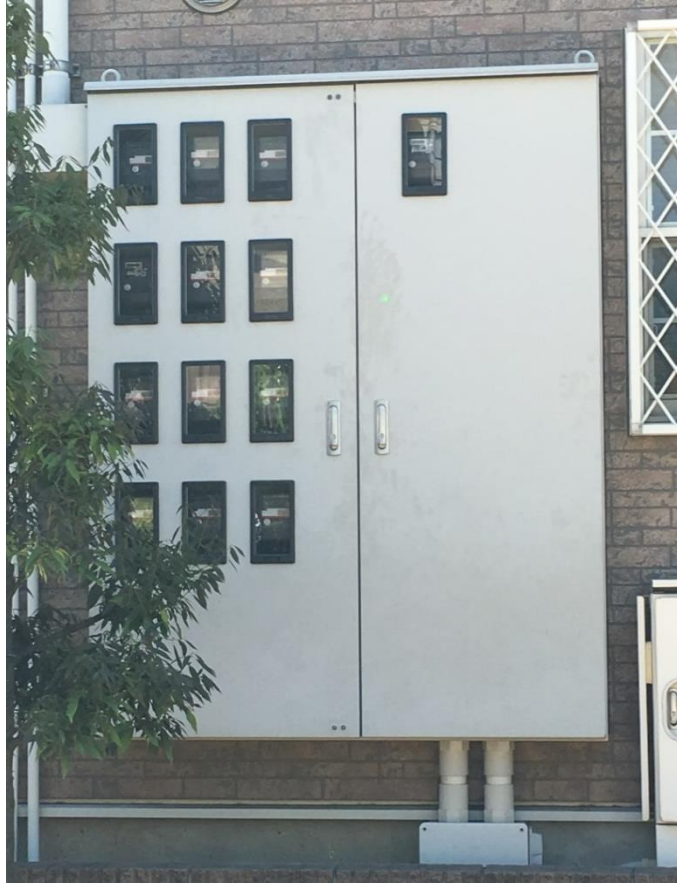
圖 23 集中式住宅電表安裝方式
