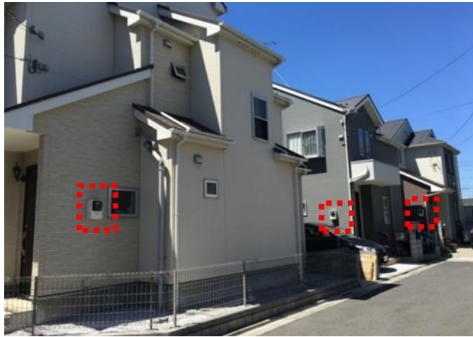
圖 24 獨棟型住宅電表安裝方式
