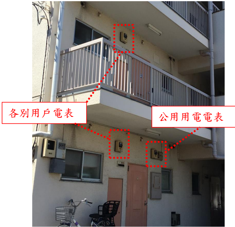
圖 25 公用用電電表安裝位置
