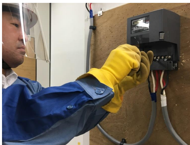
圖 31 指導員示範活線更換電表流程
