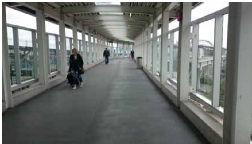
圖 35 國際航廈與國內航廈間玻璃空中走道
