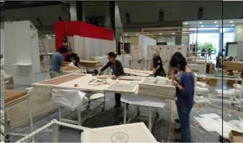
委辦廠商進行展場施工 2
