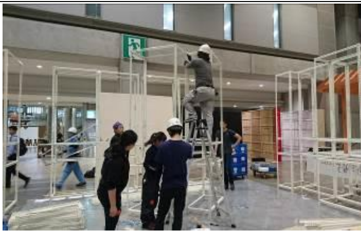
委辦廠商進行展場施工 3
