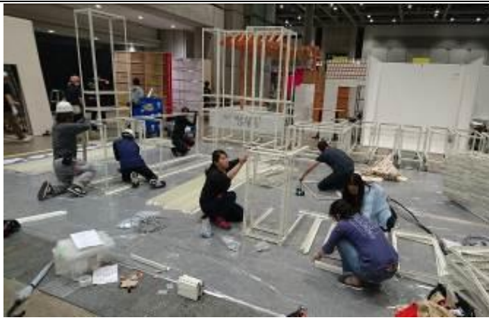
委辦廠商進行展場施工 1
