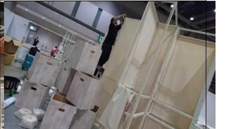
委辦廠商進行展場施工 4
