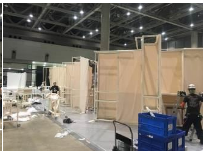
現場施工狀況 02
