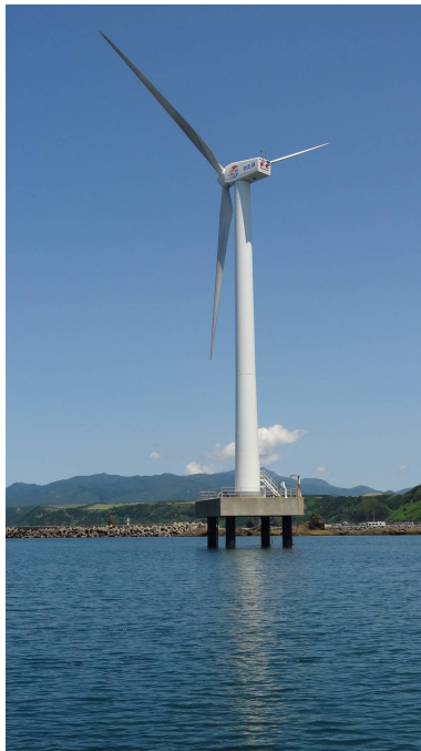
(1)風力發電機外觀
