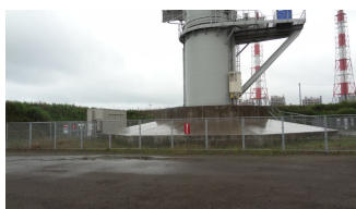
(2) 風力發電機底座
