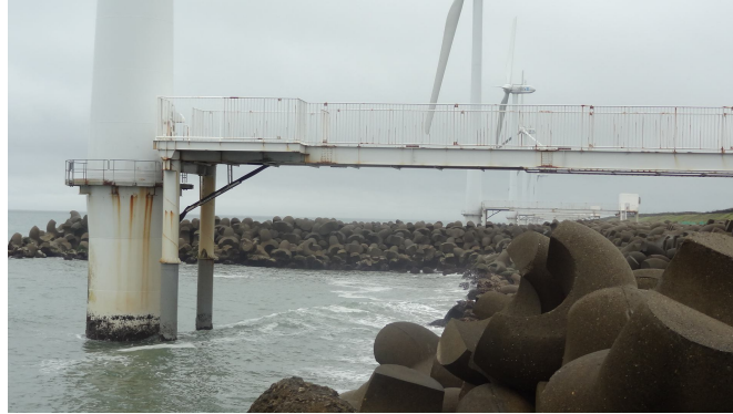
圖 8、日立 2MWx15 風力發電場
